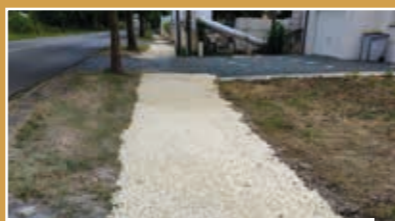
Chemin piéton, avenue de Villeneuve
